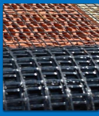
Армирование горизонтальных швов кладки стен, возводимых в сейсмоопасных регионах, с целью повышения несущей способности кладки.
